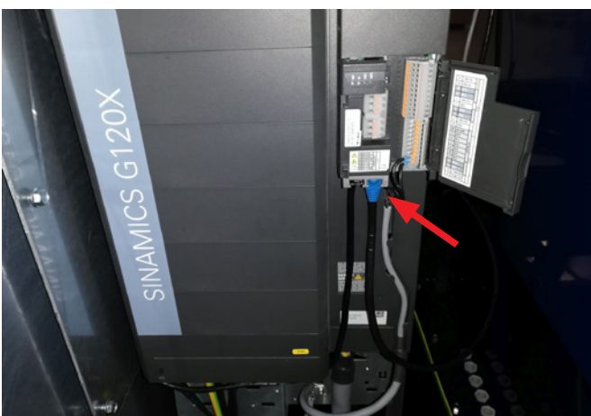
6 - Datakabeln kopplas bort från frekvensomvandlaren - illustreras här på G120X-omvandlaren
