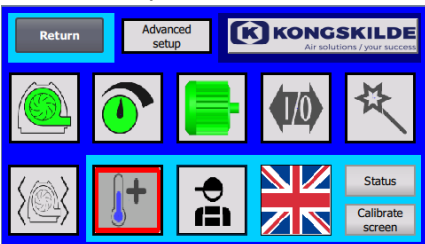
Ustawienia dla użytkownika na poziomie Admin
