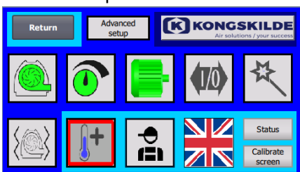
Ustawienia dla użytkownika na poziomie Admin
