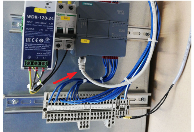
7 - Avlastningen lossas. Manöverpanelen är hakas av från styrningen och hängs på ändplattan enligt bilden. Alternativt kan den hängas på en vägg eller i ett fäste på en annan plats med hjälp av de två långhålen på baksidan
