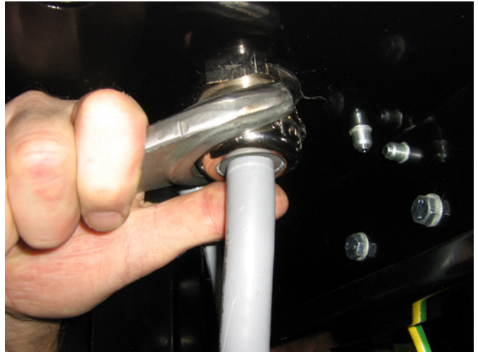
9 - apriete el prensa-estopa del cable de acometida y del cable termistor.
