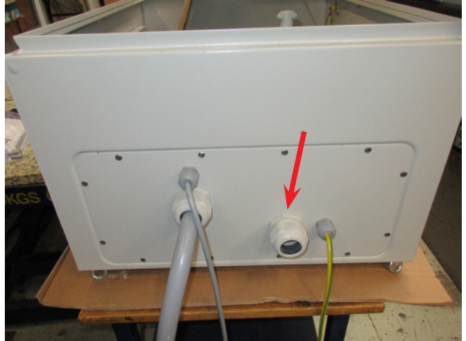
11 - la acometida eléctrica al cuadro eléctrico debe colocarse a través del prensa-estopa indicado en la fotografía.
