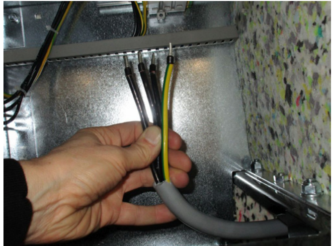
3 - Il cavo di potenza è collegato all'attacco principale e connesso in accordo alla marcatura. Puntali devono essere utilizzati. I cavi ben fissati ed il coperchio richiuso con le quattro viti.
