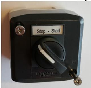
L'interruttore di avvio / arresto esterno è collegato al terminale blocco X30 tra il terminale 1 (+ 24 VDC) e 3 (digitale Ingresso 0) e un ponticello è installato tra i terminali 1 e 4.
