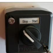
Zewnętrzny wyłącznik START/STOP jest podłączony w listwie zaciskowej X30 pomiędzy terminalem 1 (+24 VDC) a 3 (cyfrowe wejście 0), oraz pomiędzy terminalem 1 i 4 jest wpięta zworka.
