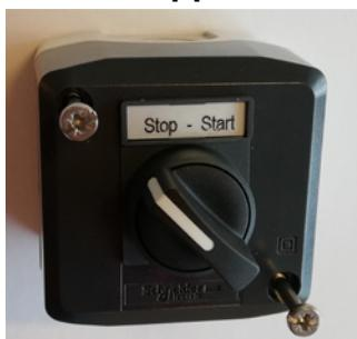
Den externa start / stoppomkopplaren är ansluten i terminalblock X30 mellan terminal 1 (+ 24 VDC) och 3 (Digital Ingång 0), och en slinga är dragen mellan terminalerna 1 och 4.
