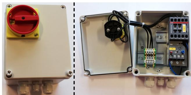
Den eksterne motorstyring tilsluttes i terminalklemme X30 mellem klemme 2 (0 VDC) og 16 (Digital Output 3), og der monteres en lus mellem klemme 1 (+24 VDC) og 12.
