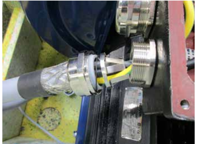
6 - Das Netzanschlusskabel wird durch die Kabelentlastung geführt, und der Entlastungsring wie gezeigt installiert.
