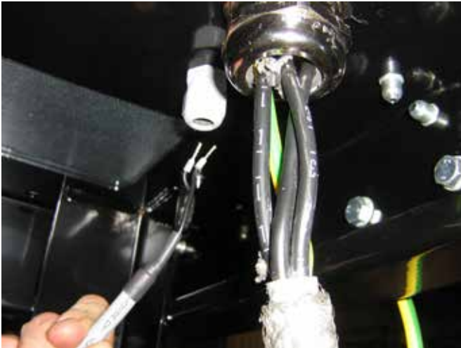
3 - pasar los cables por los prensa-estopas situados en la parte inferior de la bancada del ventilador.
