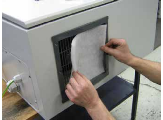
3 - Enlever le filtre, le nettoyer si besoin. Le ré-installer dans l'ordre inverse.
