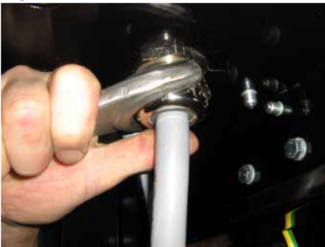
10 - spænd forskruingen for strømforsynings- og termistorkablet i bunden.
