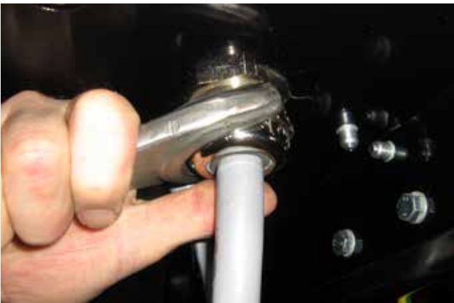
10 - Ziehen sie die Kabelentlastung für Netzanschluss- und Thermistor-Kabel an.
