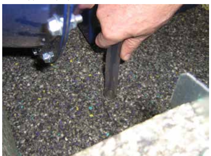
13 - forbind drænslangene og genmonter dækkapperne på blæseren.
