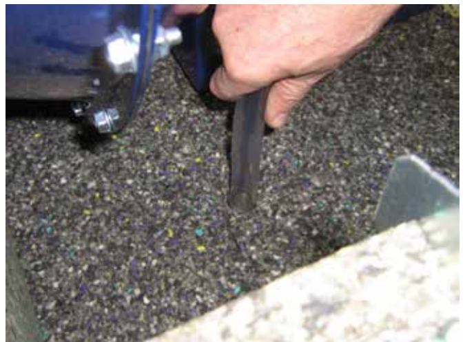
13 - Reconnecter le tuyau de drainage et remplacer les panneaux du ventilateur.
