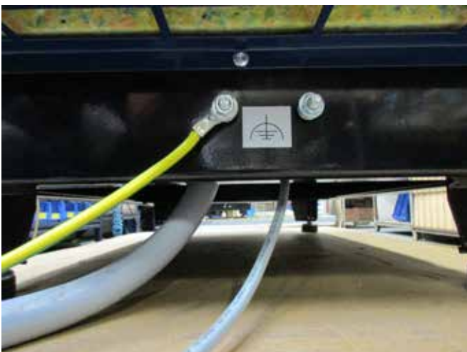
11 - monter potentialudligningskablet og spænd møtrikken forsvarligt (den højre terminal er for jordtilslutning til anlægget).
