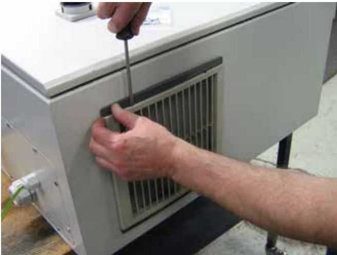
1 - Presser les deux clips pour dégager le cadre en plastique.
