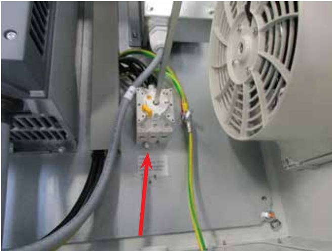
15 - strømforsyningskablet tilsluttes hovedafbryderen som vist ovenfor.
