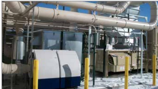
Los ventiladores MultiAir® son aptos para exteriores y tienen un bajo nivel de ruido
