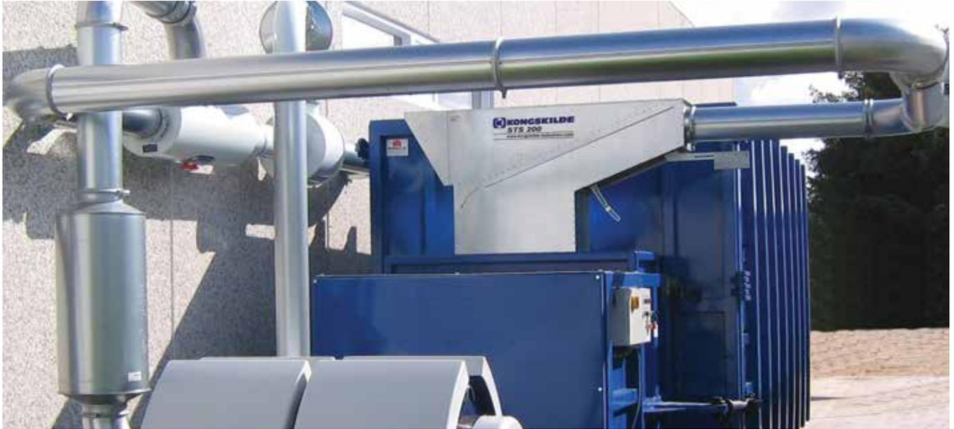
Kongskildes Sortiment an Rohrkomponenten gibt es in Durchmessern von 80mm bis hin zu 800mm. Alle Komponenten sind in verzinkter oder rostfreier sowie dünnwandiger oder verstärkter Ausführung erhältlich. Die Rohrbögen des OK100/160 Systems sind pulverlackiert. Um Etikettenabfall und andere haftende Materialien fördern zu können, ist eine Antihafbeschichtung von Innen möglich.
