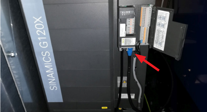
6 - Das Datenkabel wird vom Frequenzumrichter getrennt – wie hier am G120X-Umrichter gezeigt
