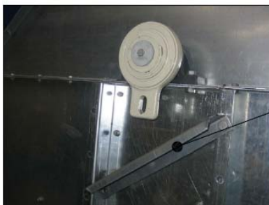
Beslag for tilbageløbsspærre, afmonteres delvis
