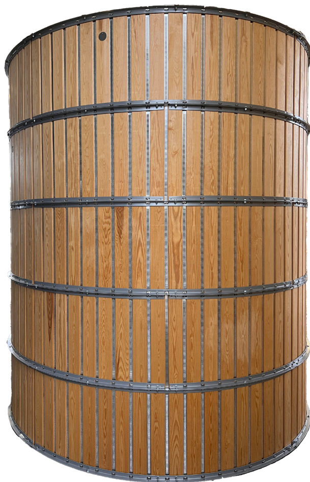
Siloerne er bygget af modulære sektioner af træ og aluminium, der er sat sammen med bøjler af vinkeljern.
