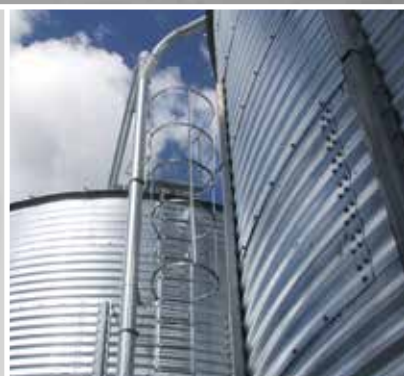
Montáž potrubí pro plnění ocelového sila na jeho vnější plášť.
