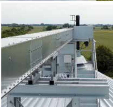
Kryt motoru při montáži pod širým nebem.
