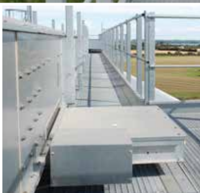
Manuálně nebo elektricky ovládaný mezivýpad v podlaze dopravníku.
