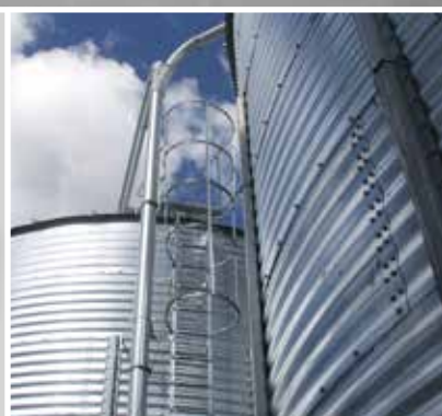
Montáž potrubí pro plnění ocelového síla na jeho vnější plášť.
