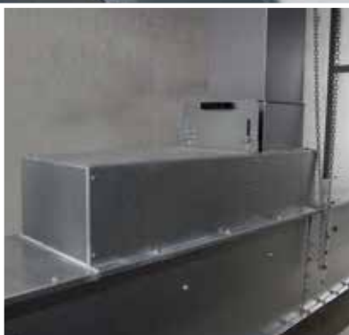
Mellemindløb med kapacitetsregulering.
