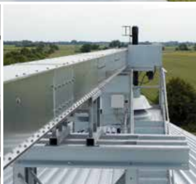
Regnskærm over motor til udendørsmontage.
