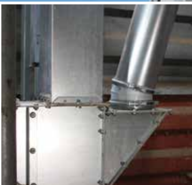
Indløb på elevatorfod.
